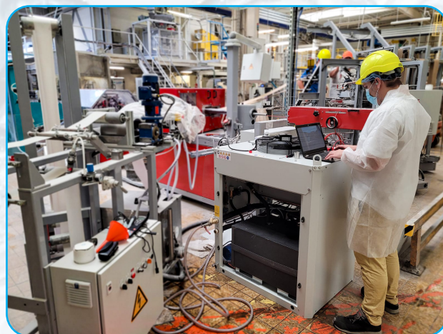
Accompagnement sur site pour vous aider à réaliser les vérifications et réglages du groupe
